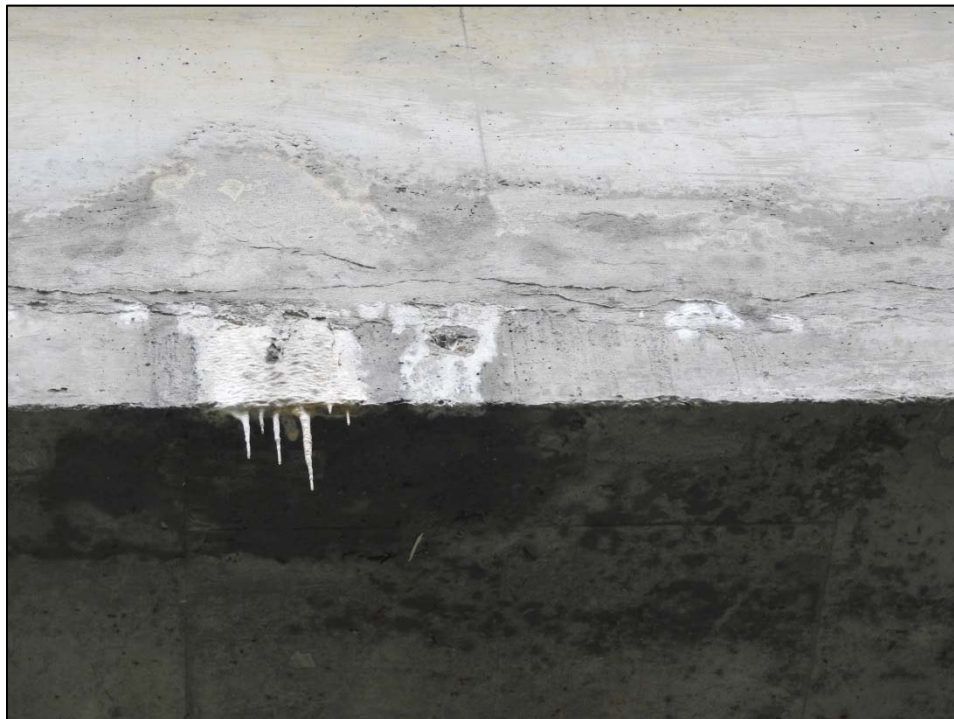
Obr. 5.12 Krápníky na pravé dolní hraně konstrukce K 04
