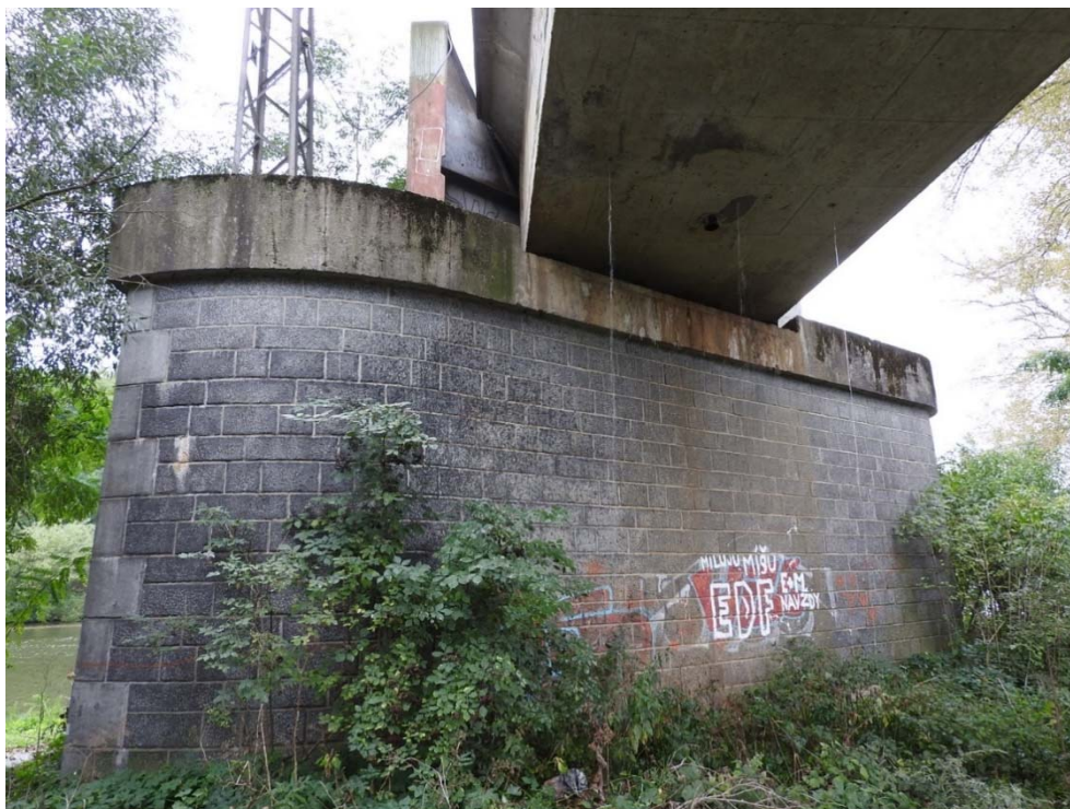
Obr. 6.19 Voda z vrtů pro endoskop u piliře P4
