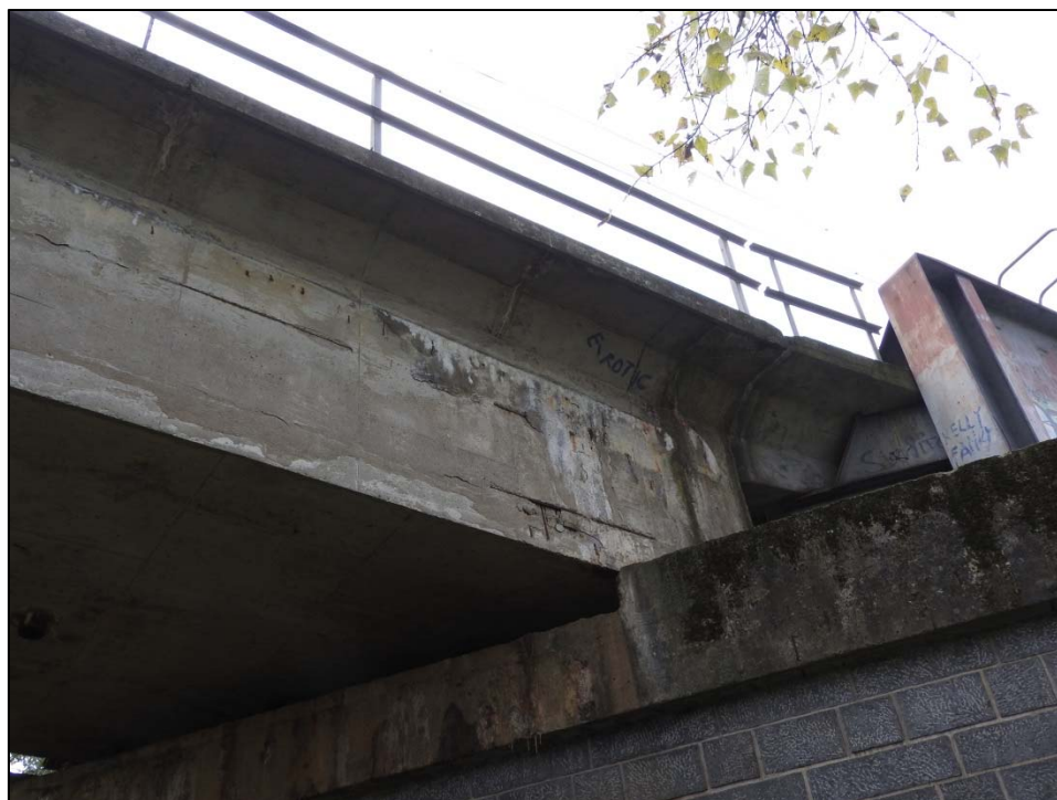
Obr. 5.1 Konstrukce K 03 v místě uložení na přechodový pilíř P 04 (levá stěna)
