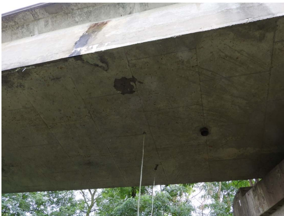
Obr. 6.20 Voda z vrtů pro endoskop u piliře P5
