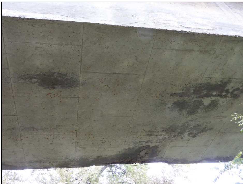
Obr. 5.11 Dolní povrch konstrukce K 04 u odtržené levé dolní hrany
