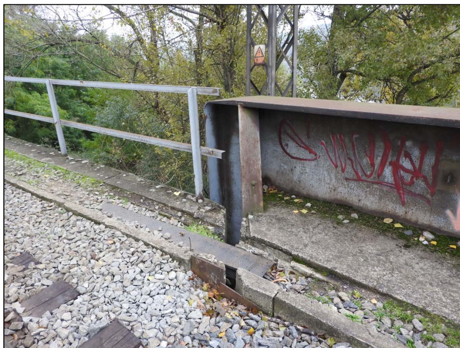
Obr. 5.30 Přechod z ocelové konstrukce K 02 na betonovou konstrukci K 03 (pohled zleva)
