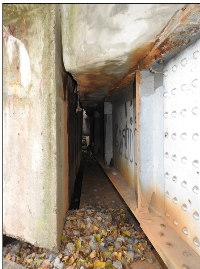
Obr. 5.19 Dilatační spára mezi ocelovou konstrukcí K 02 a předpjatou konstrukcí K 03 na pilíři P 04 (pohled zleva)
