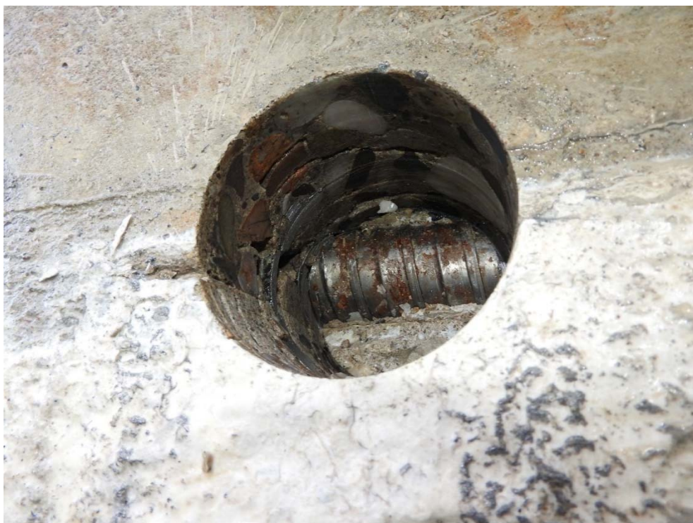
Obr. 6.6 Vrt č. 2 – trhliny v povrchové vrstvě betonu, neporušený kabelový kanálek
