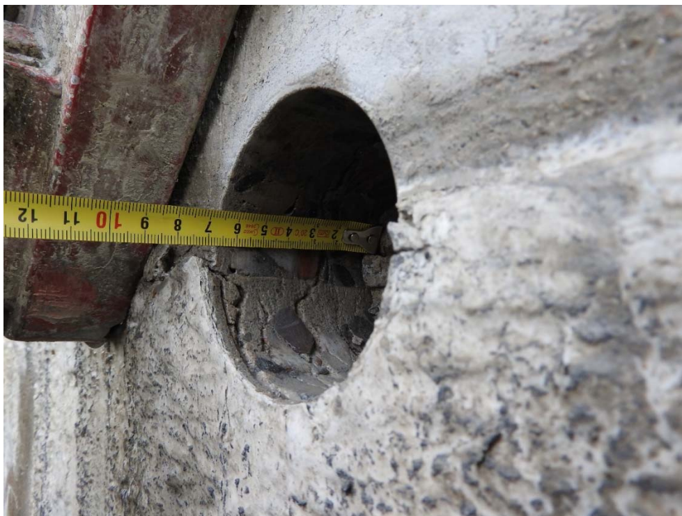
Obr. 6.7 Vrt č. 2 – trhliny v povrchové vrstvě betonu
