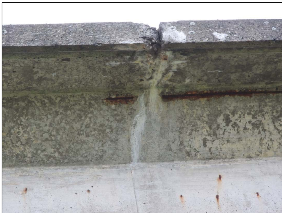
Obr. 5.13 Zatékání spárou v konzole – levá strana konstrukce K 05
