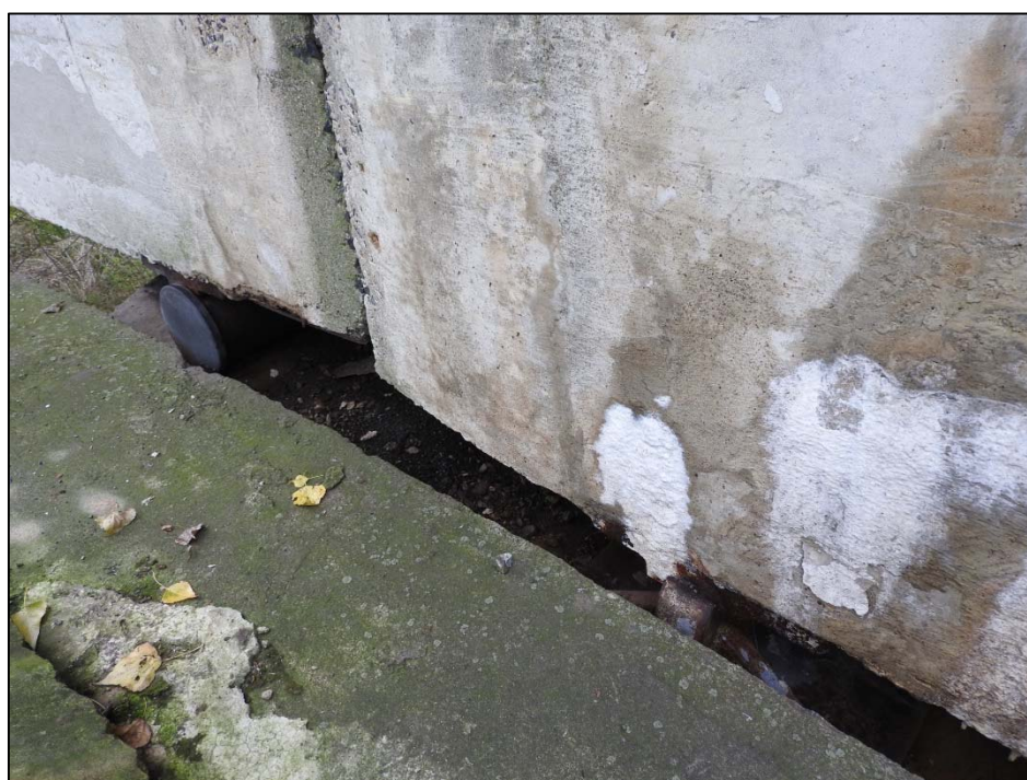
Obr. 5.24 Uložení konstrukce K 04 (vlevo) a K 03 (vpravo) na pilíři P 05 (pohled zleva)
