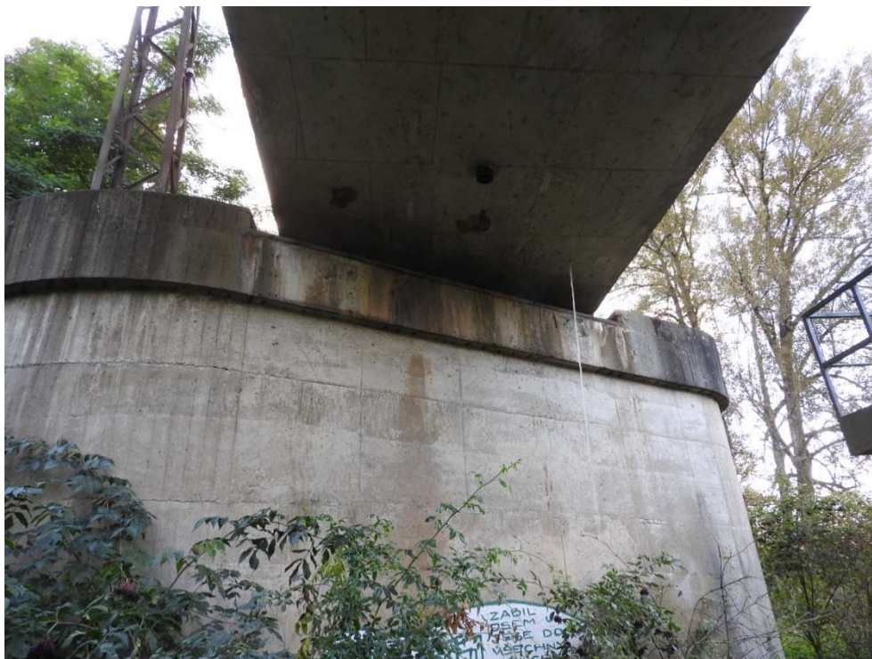
Obr. 6.21 Voda z vrtů pro endoskop u piliře P6
