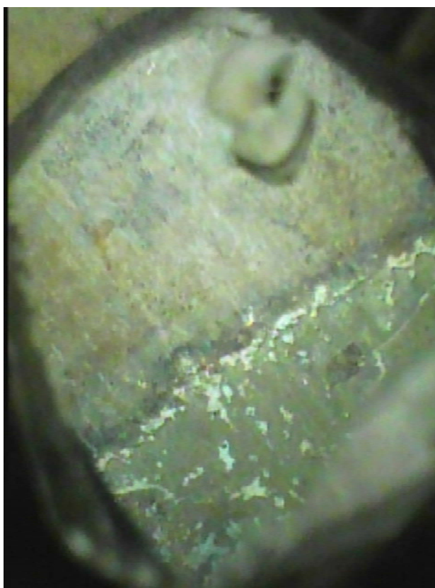
Obr. 6.26 Vnitřní plocha stěny s výluhy pojiva – komora k8 (vpravo nahoře je kapka vody na kameře)
