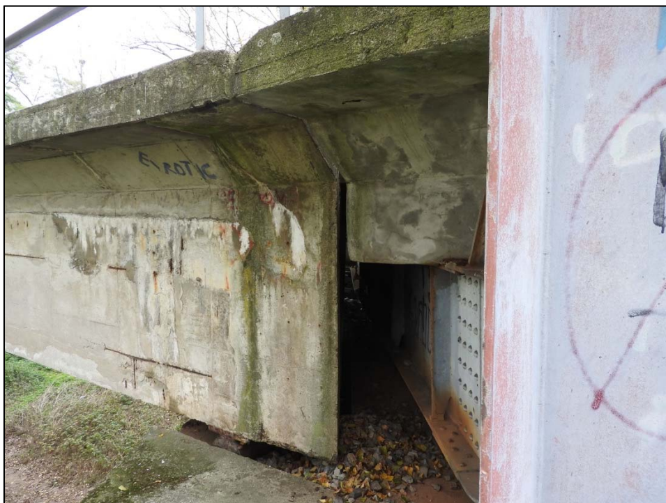
Obr. 5.18 Dilatační spára mezi ocelovou konstrukcí K 02 a předpjatou konstrukcí K 03 na pilíři P 04 (pohled zleva)
