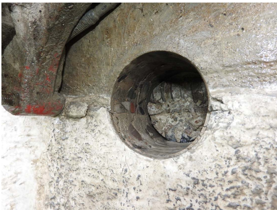
Obr. 6.4 Vrt č. 1 – trhliny v povrchové vrstvě betonu, neporušený kabelový kanálek; je viditelná vodorovná pracovní spára mezi povrchem dolní desky a stěnou
