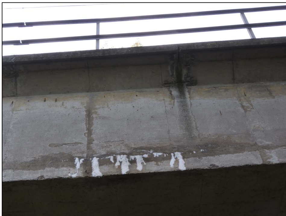
Obr. 5.2 Levá strana konstrukce K 03 – výluhy pojiva v pracovní spáře nad dolní deskou
