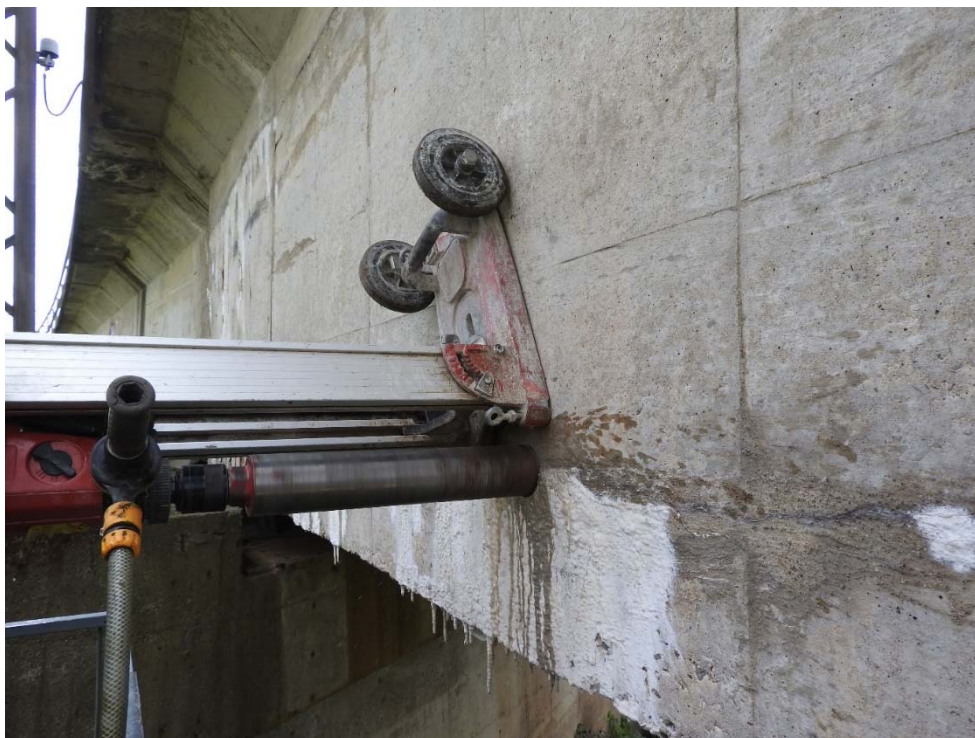
Obr. 6.3 Provádění vrtu č. 1
