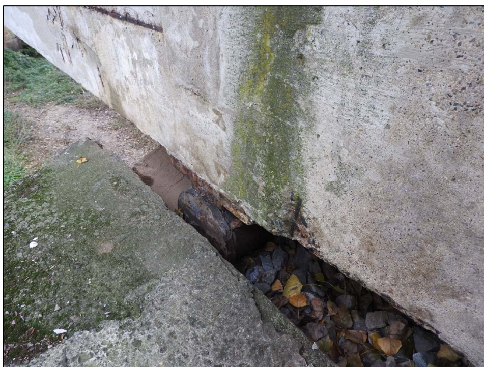
Obr. 5.21 Uložení konstrukce K 03 na pilíři K 04 na válcová ložiska – pohled zleva
