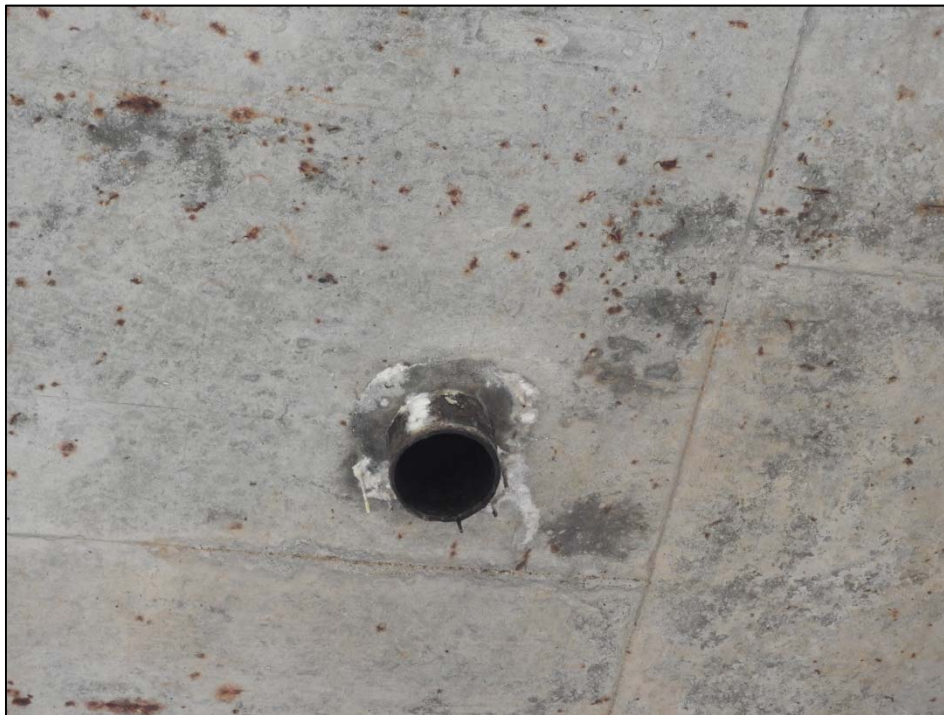
Obr. 5.5 Dolní povrch konstrukce K 03 u piliře P 04 – krápníky u odvodňovacího otvoru, stopy koroze na betonu
